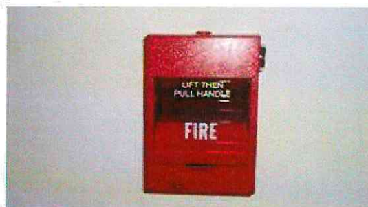
Alarma y Pulsador de Incendio o de Emergencia Y Pulsador para abrir puertas de los pisos
