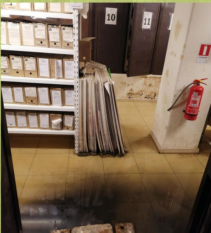
mente la que bota las aguas desde el edificio del GORE hacia Bandera. La cámara donde llegan las descargas se encuentra en el -1 y luego avanza por un tubo a la red de alcantarillado, precisamente a la misma altura del estropicio. No es descabellado pensar que una pequeña fisura haya hecho que el agua escurriera y que con el tiempo afectara principalmente a quien tiene más pisos de profundidad, en este caso BancoEstado. Y cuando las aguas rebasaron el suelo, esta subió hacia el GORE.
